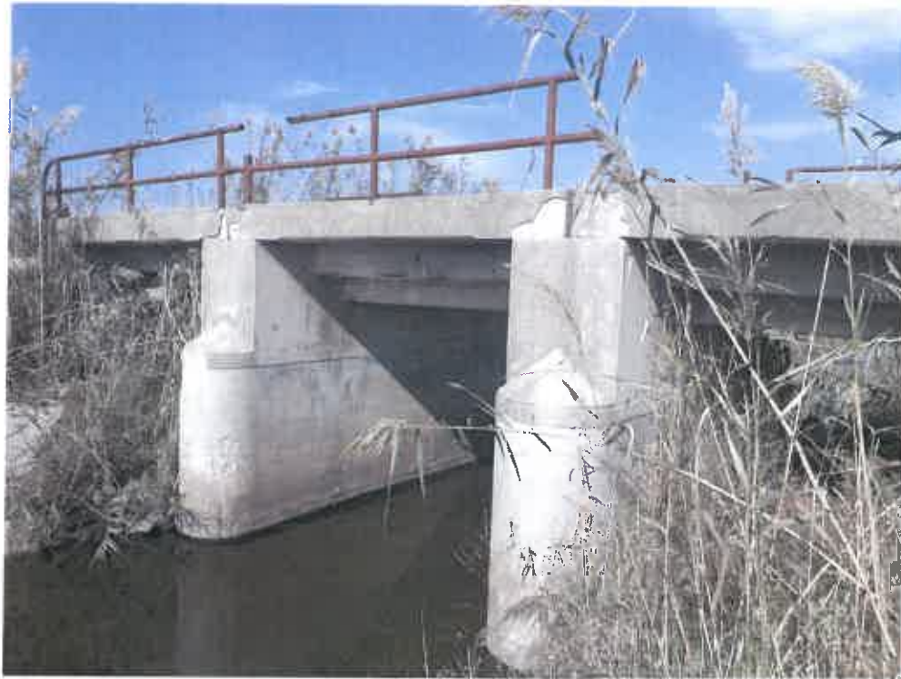
Ponte Str. 14 Est
