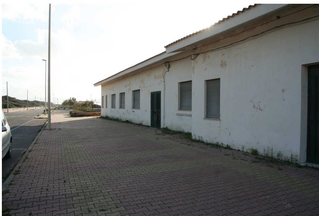
Ex colonia prospetto lato Est
